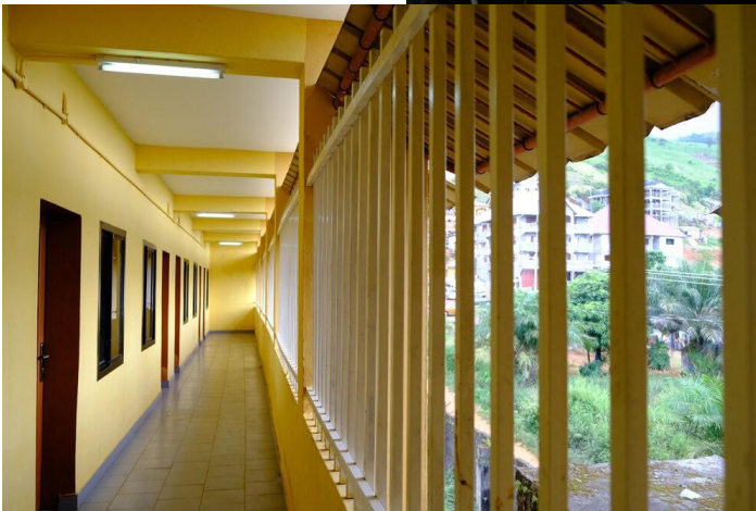
La sala de MDR-TB, el año pasado en plena construcción. Las habitaciones de los pacientes
